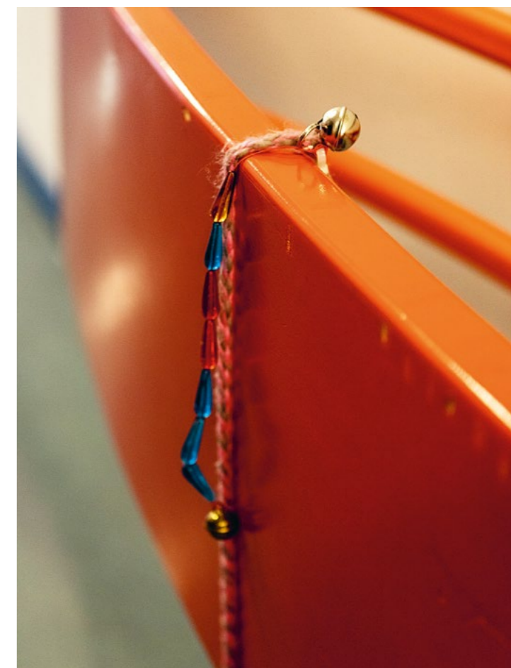
Das Geländer im Flur der Schule zeigt durch unterschiedliche Vibrationen den Ort des jeweiligen Klassenzimmers.
